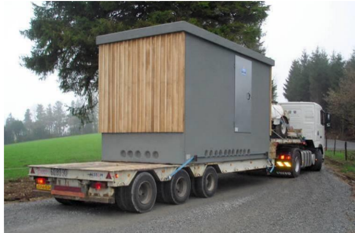
Illustration 8 : Arrivée d'un poste de livraison sur un site éolien
