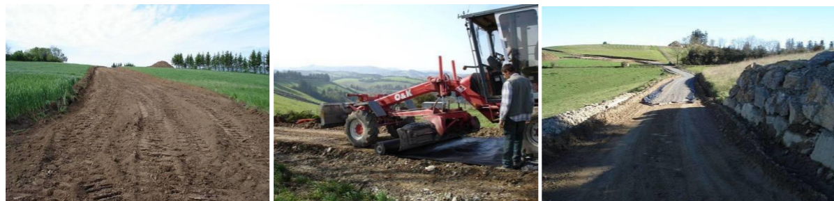
Illustration 12 : Tracé de la piste | Illustration 13 : Pose du géotextile | Illustration 14 : Mise en place du gravier
