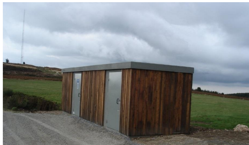
Illustration 9 : Poste de livraison du parc éolien du MARGNES (81)
